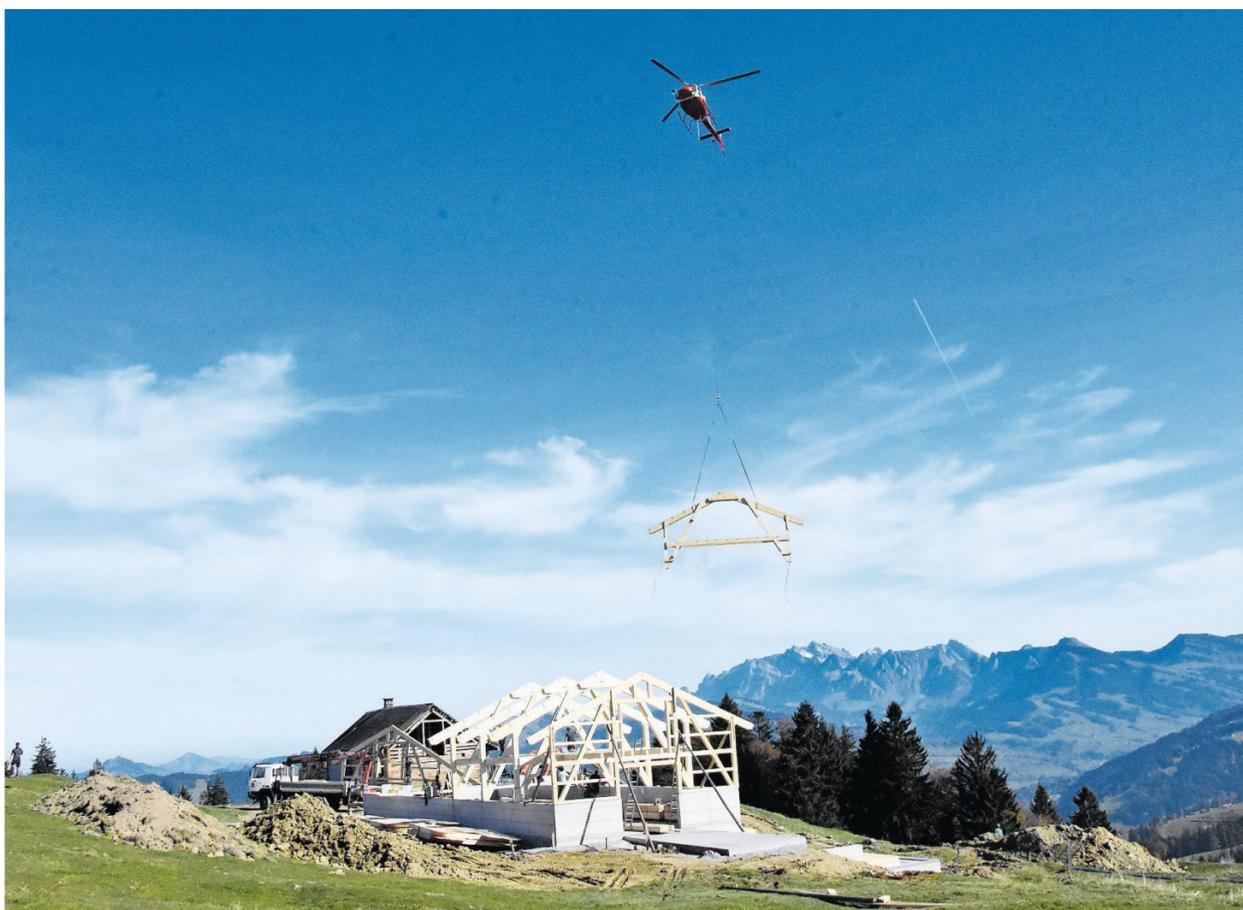
**Luftpost** Gestern Freitag transportierte ein Heli der Firma Swiss Helicopter ganze Bindekonstruktionen vom Berghaus Girlen aus auf den Oberen Hüttenbühl oberhalb Ebnat-Kappel für den Bau eines neuen Alpstalls. Direkt vor Ort montierten Arbeiter die vorgefertigten Module, welche je rund 1200 Kilogramm wiegen.
