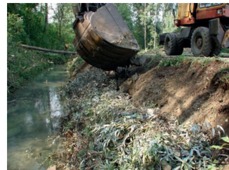
Einbau einer Faschine
