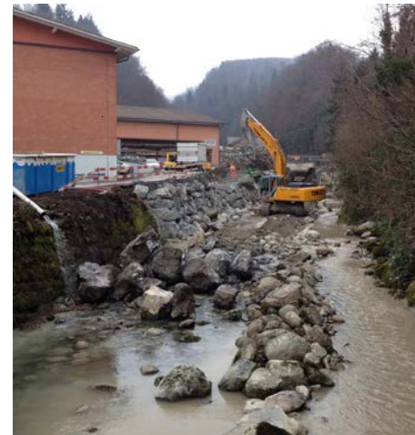
Ersatz einer Ufersicherung
