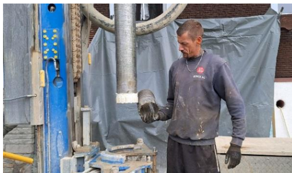
Austausch einer Diamantbohrkrone
