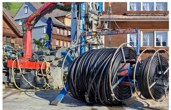
250 m Sonde liegen zum Absenken bereit
